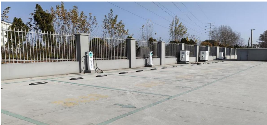
图片 8.4 充电桩改造后
